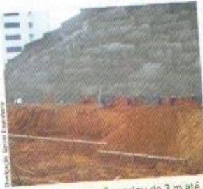
A altura da contenção variou de 3 m até 32 m, em solo grampeado. Inclínômetros foram implantados para medir a variação da maciço do solo
