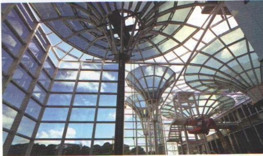
Os ângulos dos vidros foram cuidadosamente medidos para formar a curvatura das tulipas. Os vidros têm formato trapezoidal e os vidros do canto, que fecham os cálices, têm trapezoides com ângulos e seções diferentes
